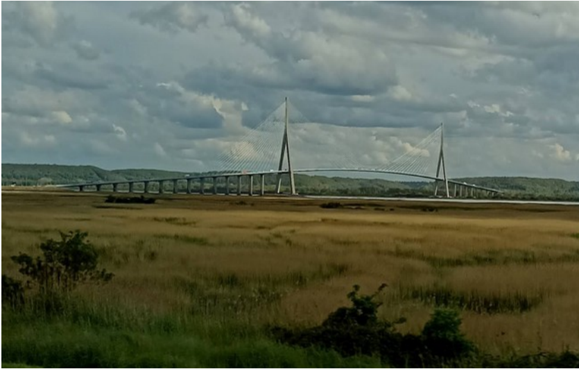
Pont de Normandie
