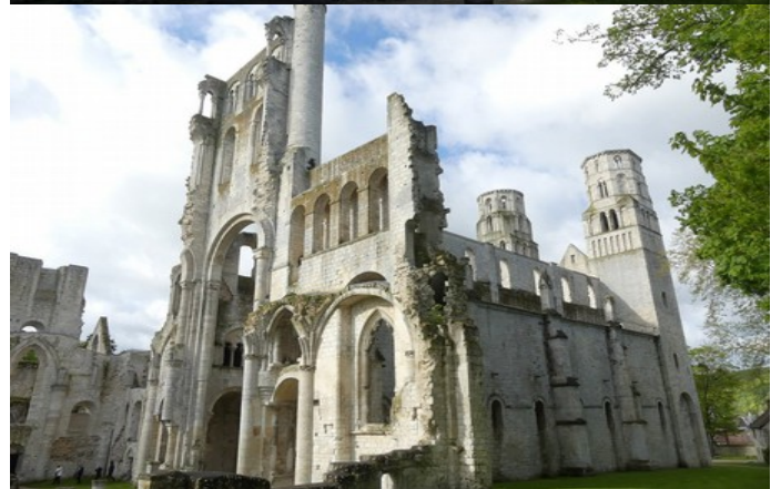
Jumièges transept détruit et façades Nord
